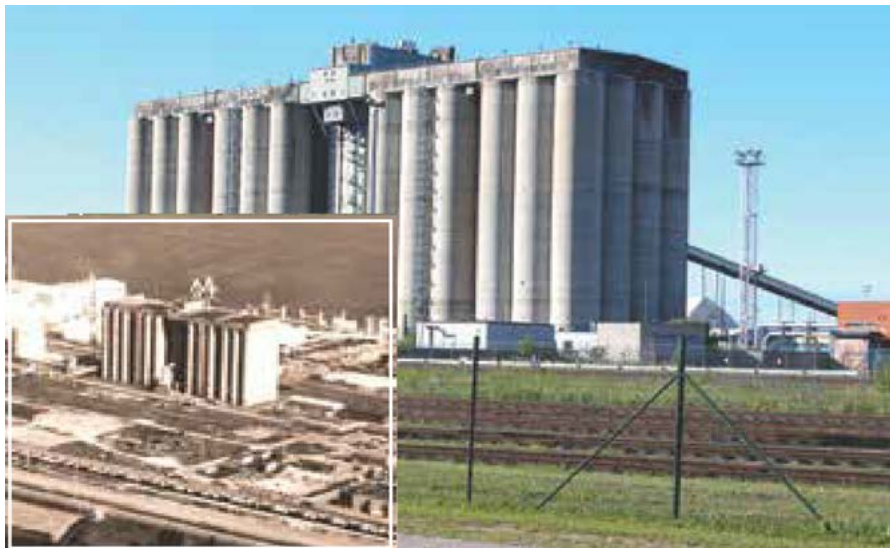
Элеватор в порту Мууга, построенный в 1986 году по самым современным требованиям, и сегодня мог бы использоваться по назначению. Он и используется, но значительно меньше, чем позволяют его возможности.
