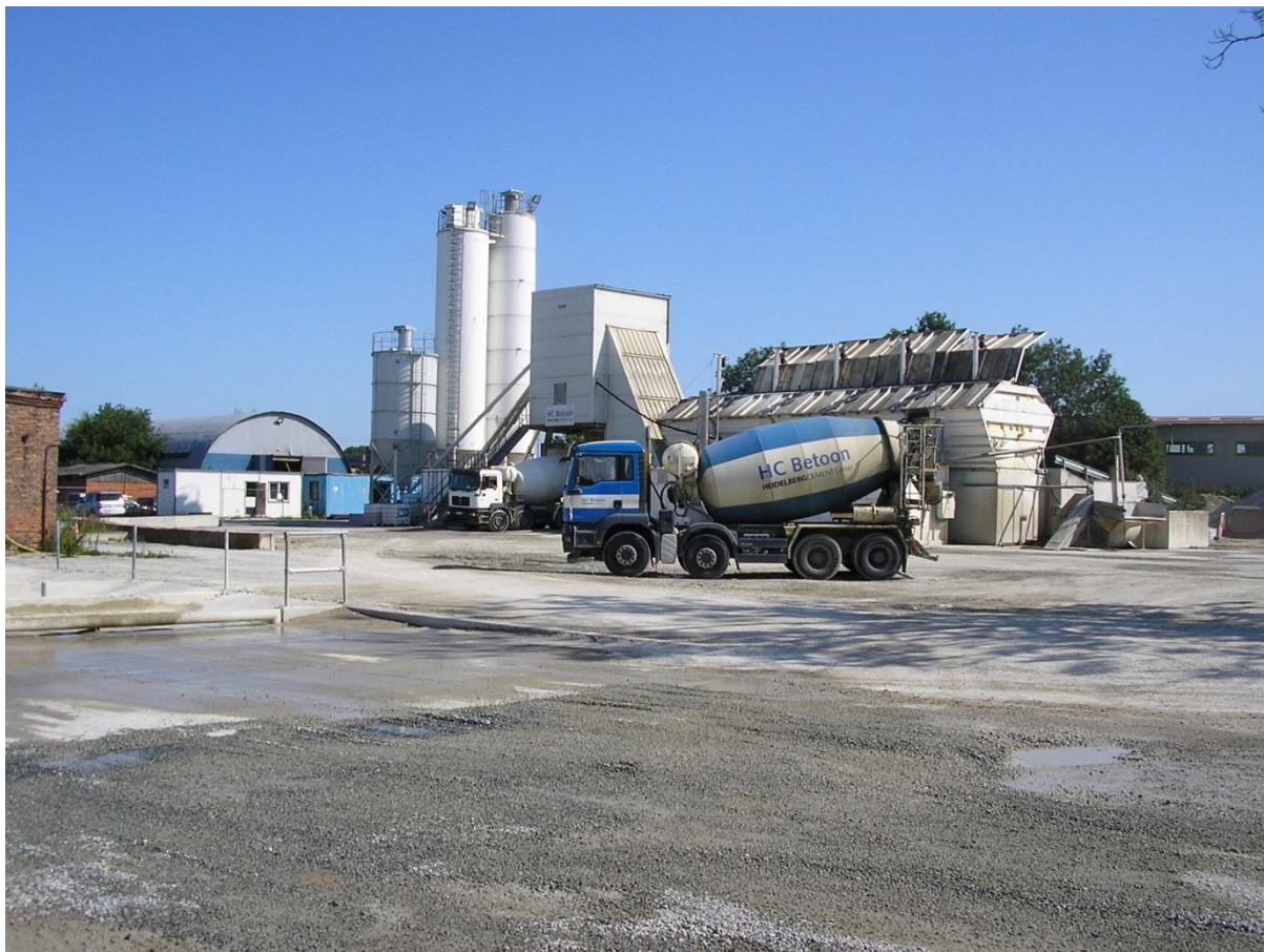
Joonis 2. Vaade olemasolevale betoonitehasele.
